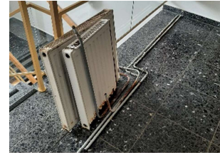
5: Die ausgetauschten Heizkörper
