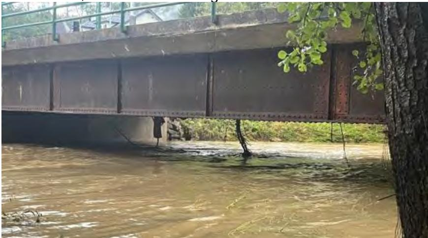
18.09.2024, nach dem Hochwasser, die Schwerlaststeher sind nicht mehr sichtbar, sie wurden durch das Hochwasser weggerissen.
